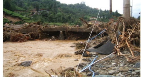
Şekil 1 - Doğu Karadeniz Havzası'nda taşkın anında biriken sediment ve odunsu malzemenin köprü vb. yapıların kesitlerini tıkaması (Trabzon Beşikdüzü İlçesi ve Rize İyidere İlçesi Taşkınları)
