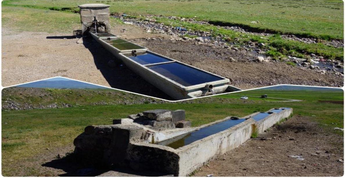
Şekil 16. Erzurum ilindeki metal ve betondan yapılmış su yalağı örnekleri Figure 16. Examples of water troughs made of metal and concrete in the province of Erzurum
