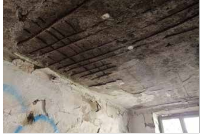
Figure 24: Roof slab (soğukluk) in the bath complex (Eken 2020). / Hamam yapısında soğukluk mekânı üzerindeki tavan döşemesi (Eken 2020)
