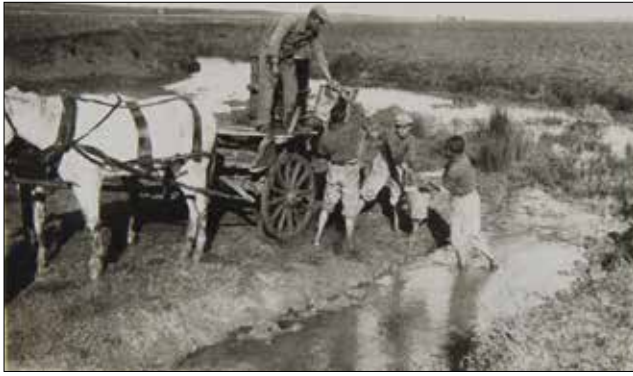
Figure 14: Transporting water from the river to the construction site in buckets before establishing the water canal (IHTBV). / Su kanalı inşasından önce nehirde inşaat alanına kovalarla su taşınması (IHTBV)
