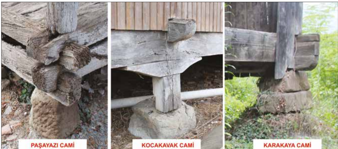
Fotoğraf 2: Camilerde görülen temel detayları (Furtuna 2018) / Details of the foundations in the mosques (Furtuna 2018)
