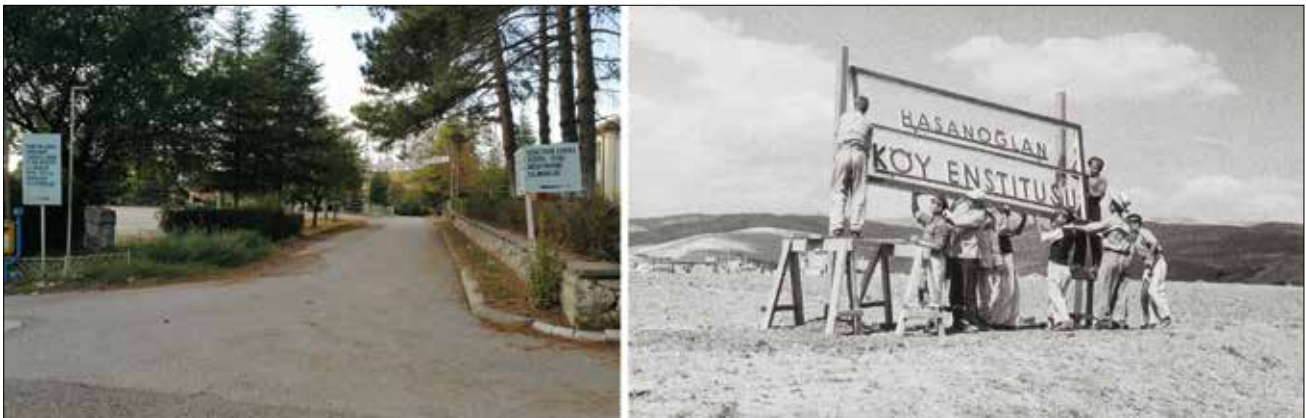
Figure 3: General view of the HVI site at present (left; Eken 2020) and its steppe situation in 1941 (right; İsmail Hakkı Tonguç Belgeliği Vakfı (IHTBV) (İsmail Hakkı Tonguç Archive Foundation). / Hasanoğlan Köy Enstitüsü'nün mevcut genel görünümü (solda; Eken, 2020) ve alanın 1941'deki bozkır görünümü (sağda; IHTBV).
