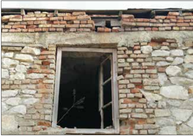
Figure 30: Unity of the brick-stone masonry wall, reinforced concrete slab, and wooden window in the bath complex (Eken 2020). / Hamam yapısındaki yığma taş-tuğla duvar; betonarme döşeme ve ahşap pencere birlikteliği (Eken 2020)
