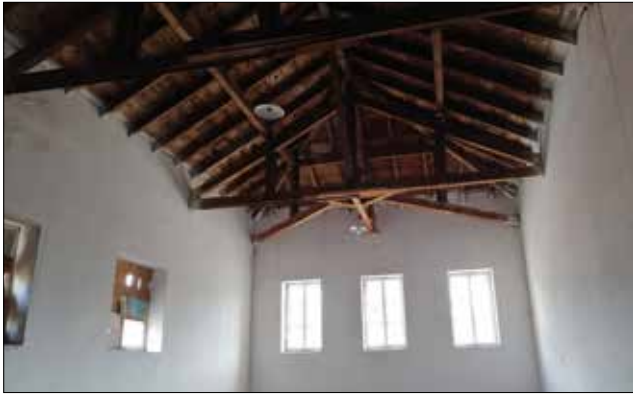
Figure 27: Gable roof of a storage building from the inside (Eken 2020). / Depo binasının iç mekânından beşik çatının görünümü (Eken 2020)
