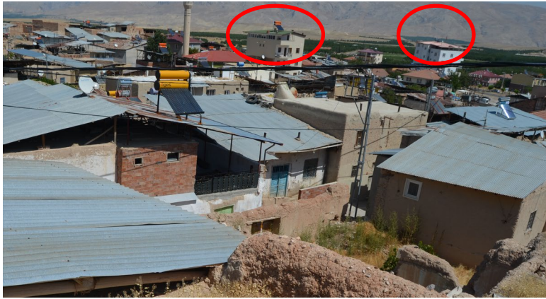
Şekil 11. Balaban'ın genel görünümü içinde dikkati çeken betonarme yapılar (2017)
