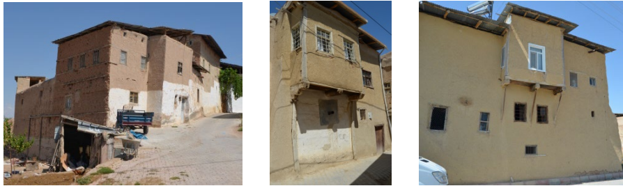
Şekil 8. Balaban'da bulunan kerpiç malzemeli yapı örnekleri (2017)
