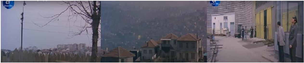
Şekil 3: Gecekondu avlusundan apartmanlar, gecekondu mahallesi ve fabrika (Gelin)
