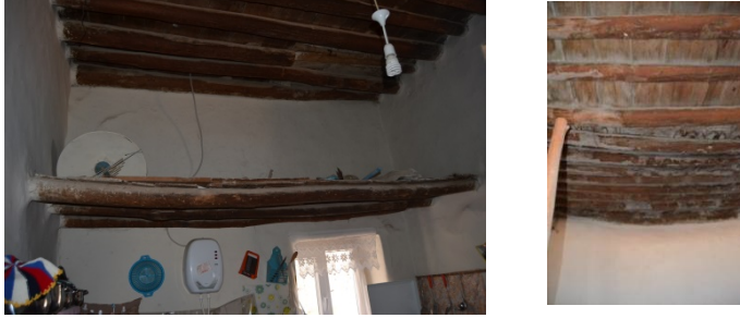
Şekil 9. Balaban'da bir konut yapısının iç mekânında ahşap malzeme kullanımı (2017)
