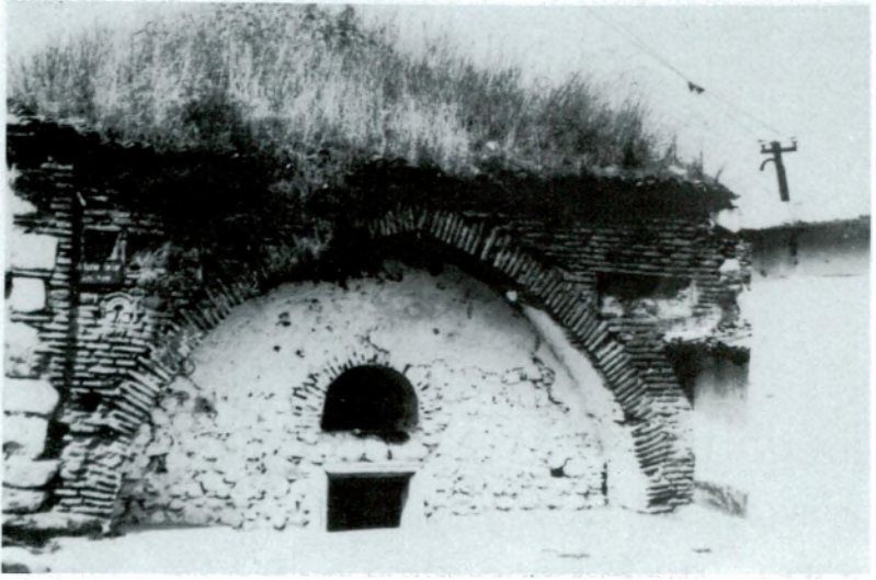
Res. 7 — Yedikızlar Türbesinin Doğu Cephesi
