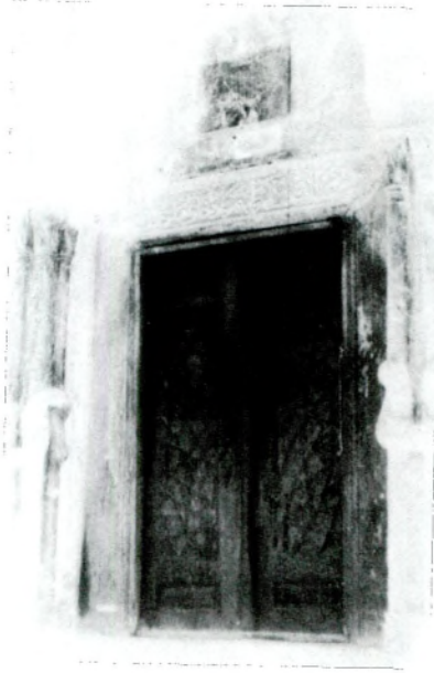
Res. 6 — İshak Çelebi Türbesinin Giriş Cephesindeki Sütunlar
