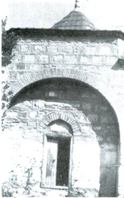
Res. 4 — Revak Sultan Türbesinin Giriş Cephesi
