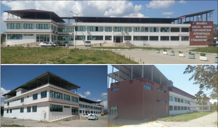
Şekil 1. Köprübaşı Meslek Yüksekokulu Binasının Cephe Görünüşleri
