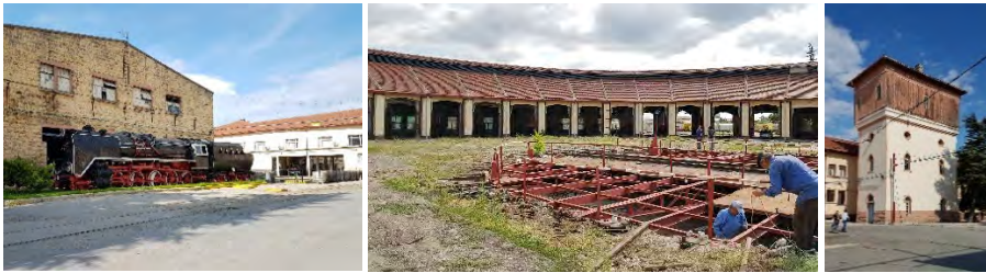
Şekil 18-19-20. Lokomotif Fabrikası ve Karakurt, dairesel planlı lokomotif deposu ve su deposu (Kişisel Arşiv, 2018).
