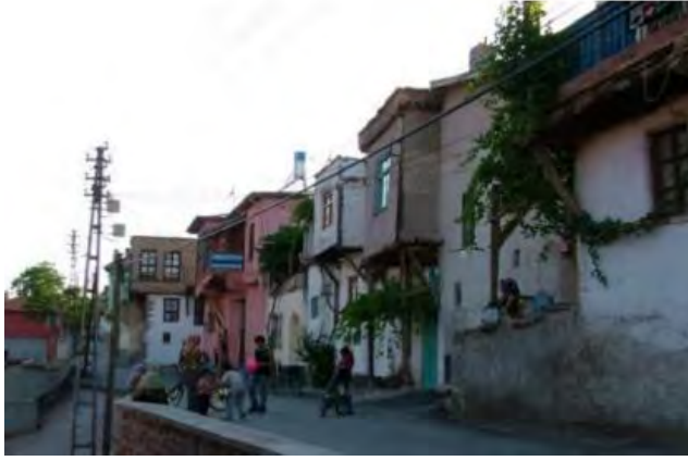
Şekil 2. Sille evlerinin genel görünüşü (Aklanoğlu, 2009)
