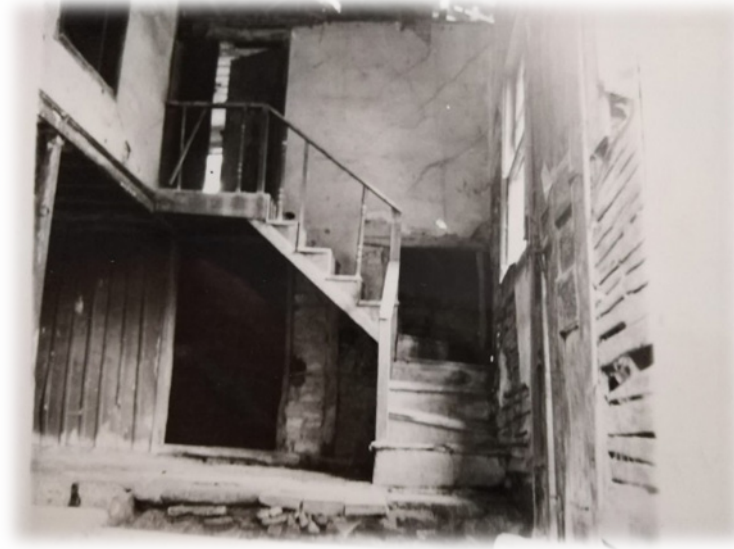
Şekil 16. Canbaziye Cami Avlusunun Sağ Tarafında Kalan Şeyh Odası ve Mahfel Merdiveni 1940'lı Yıllar 89
