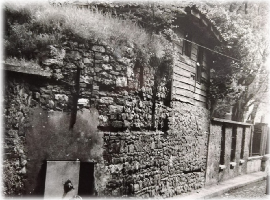
Şekil 11. Canbaziye Cami, Yanındaki Medrese Arsası ve Haziresi, 1940'lı Yıllar 71
