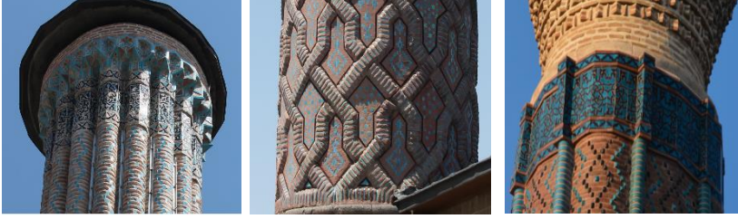
Resim 13: Erzurum Çifte Minareli Medrese, minare
