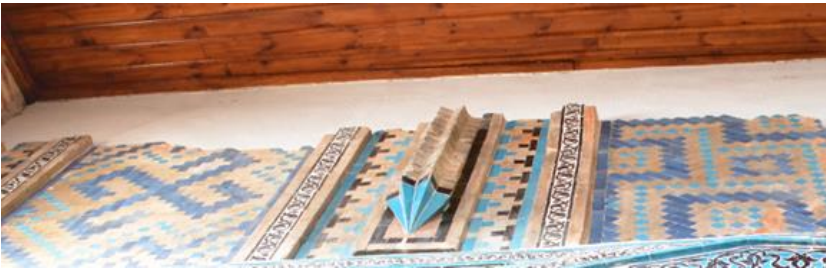
Resim 5: Sahip Ata Türbe, giriş koridor, batı duvar
