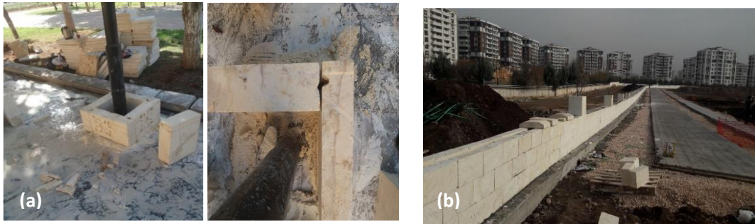
Şekil 8. (a) Urfa taşına oluk açılarak kenetlenmesi; (b) Urfa taşı kaplama
