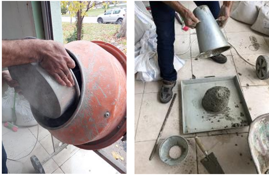
Şekil 4. Betonun karıştırılması ve çökme değerinin bulunması
