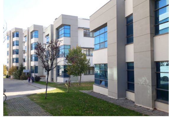
Resim 9. Tıp Fakültesi Dekanlık Binası, 2021 [52]
