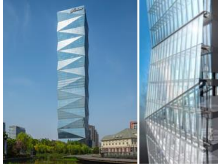
Şekil 9: Jinao Tower ve Çift Cidarlı Cephe Sistemi (Architizier, 2020; İlter, 2018).
