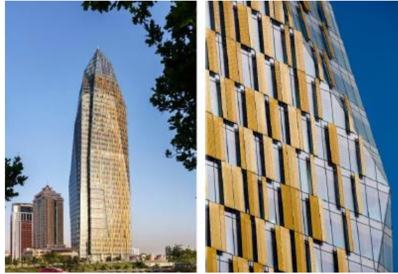
Şekil 3: Güneş Kontrollü Cam Giydirme Cephe Sistemi (Aydın, 2017).
