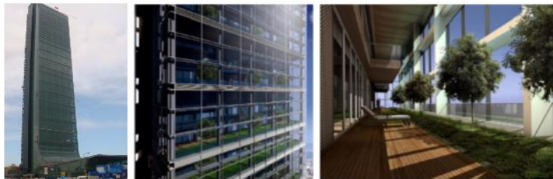
Şekil 10: İstanbul Sapphire İç ve Dış Cepheler (Erturan, 2010; Aydın, 2017).
