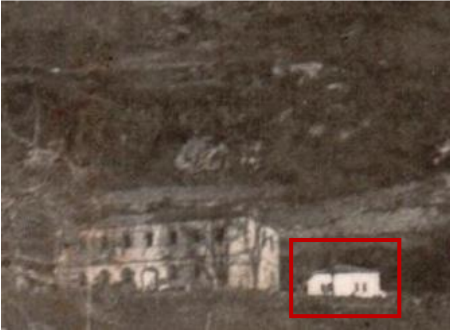
Görsel 16: Redif Deposu (Sol) ve Redif Dairesi (Sağ) 42
