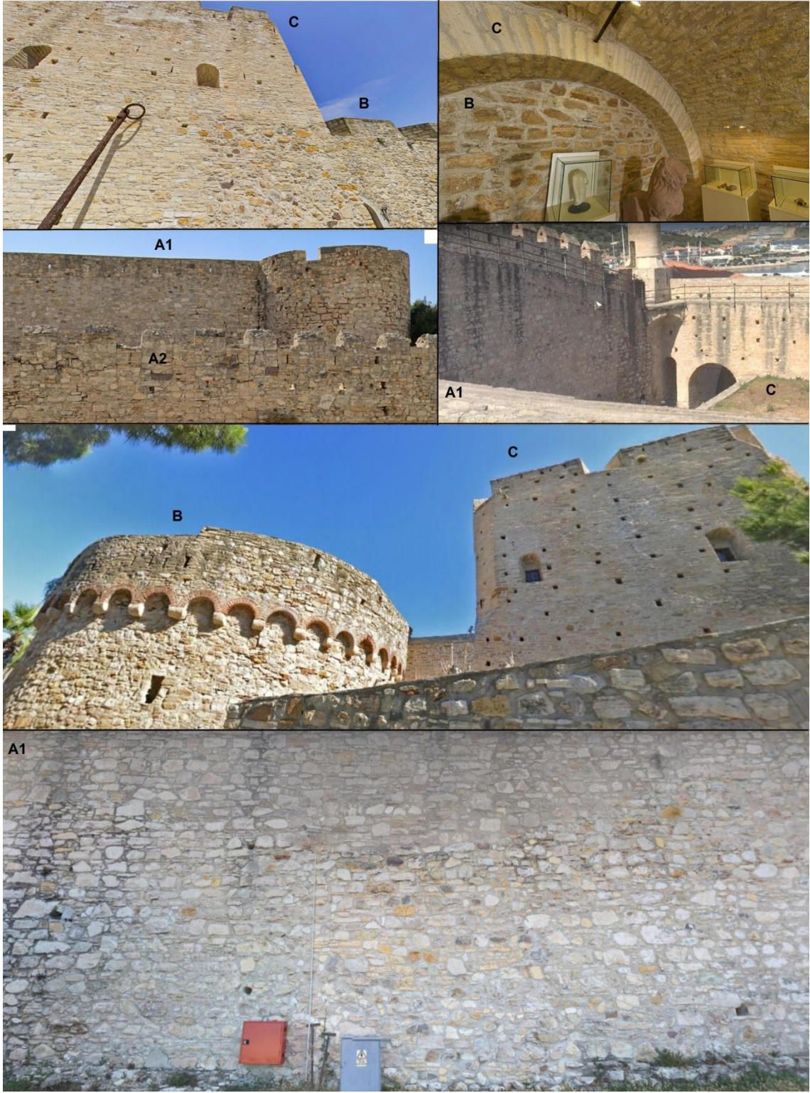
Şekil 5. Farklı Duvar İşçiliklerinden Örnekler
