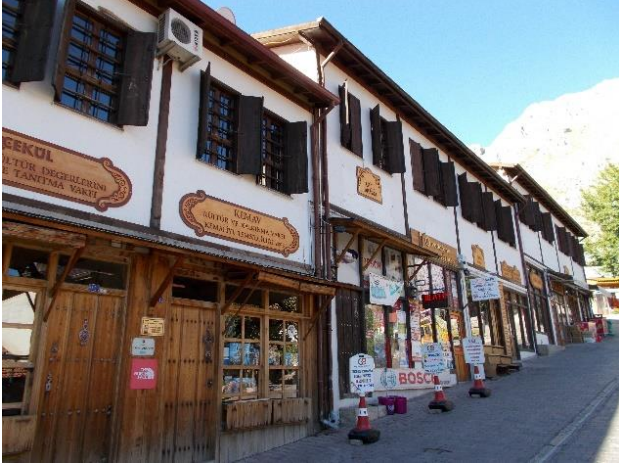
Resim 1. Koruma – Onarım Çalışmaları, Kemaliye
