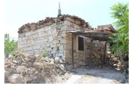
Resim 16. Tescilli Olmayan Yapı Örneği
