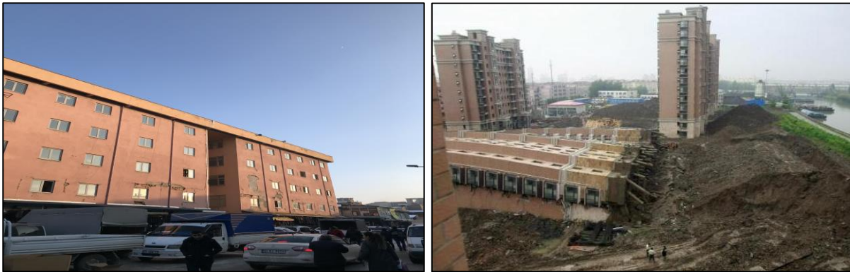
Şekil 3. Depremde taşıyıcı elemanları hasar görmüş ve zemin sıvılaşması olmuş bina örnekleri
