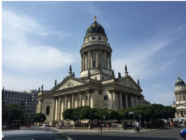
Image 6: General view of the steeple section of the Deutscher Dom.
