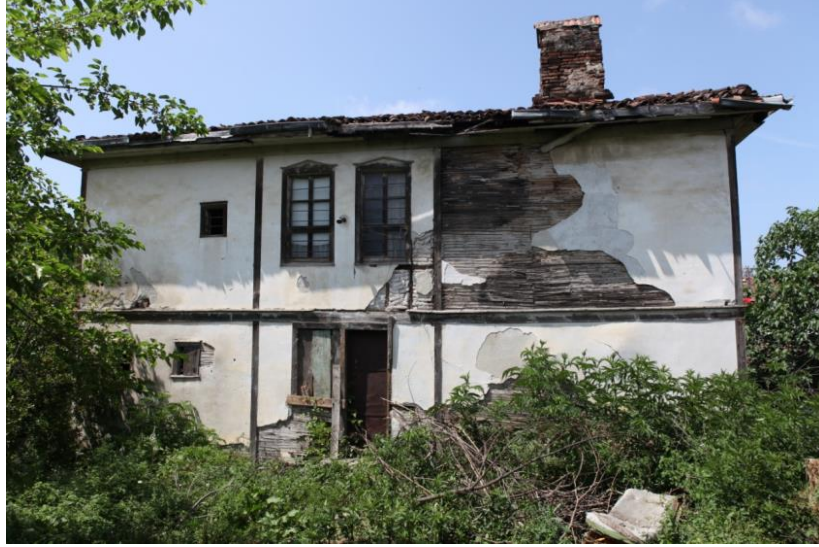
Görsel 11: Güney Cephesi.
