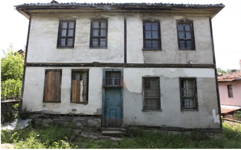
Görsel 12: Doğu Cephesi.
