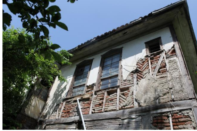
Görsel 45: Tuğla Dolgulu Ahşap Çatkılı Duvar Detayı.
