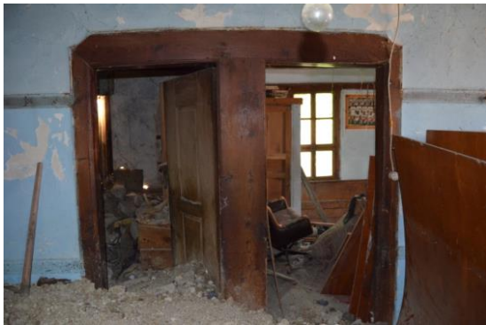
Görsel 17: Zemin Kat Oda Kapıları.
