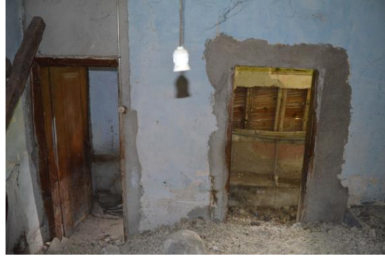
Görsel 20: Zemin Kat Sofanın Güneybatısında Yer Alan Mekân.
