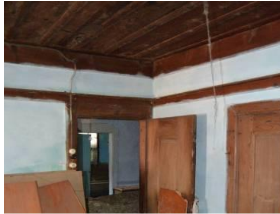
Görsel 39: Ahşap Pasalı Tavan Uygulaması.
