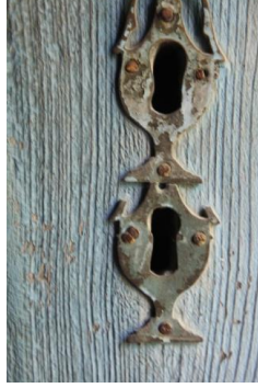
Görsel 37: Zemin Kat Doğu Cephesi Bahçe Kapısı Kilit Detayı.
