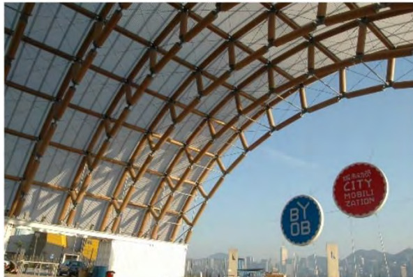
Şekil 12: Taşıyıcı karton tüplerin kafes yapım sistemiyle kemer formunda kullanımı (URL-13)
