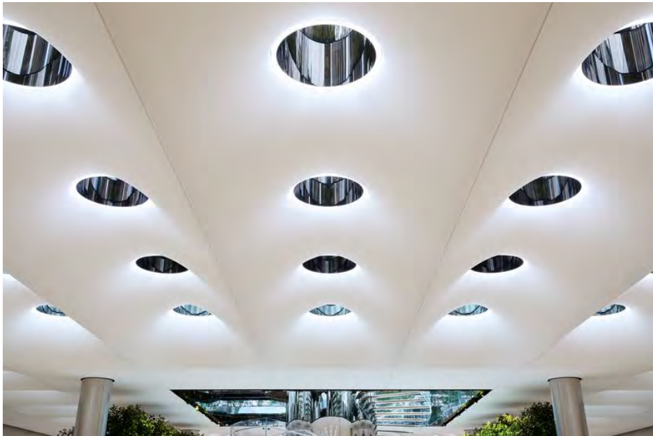
Şekil 13: Tavandaki tepe pencerelerinden gün ışığının dağılımı ve etrafını çevreleyen sensörlü LED armatürler (URL-7)
