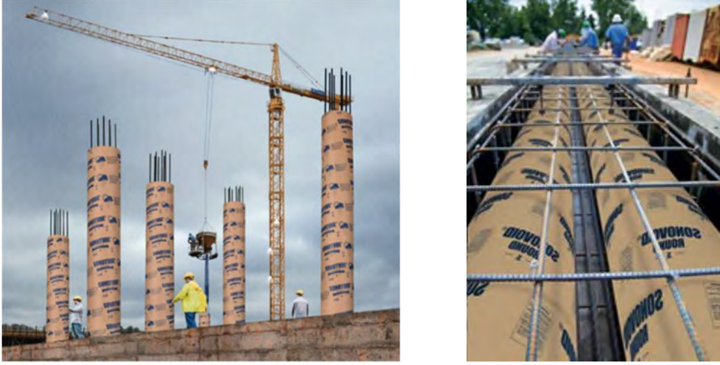
Şekil 9: Karton tüplerin betonarme kalıplarda kullanımı (URL-9) (URL-10)
