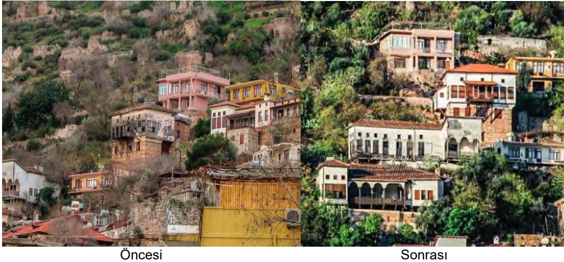
Şekil 4: Emine-Murat Kocak Evi'nin restorasyon öncesi ve sonrası hali (Koçak, 2016, s.312)
