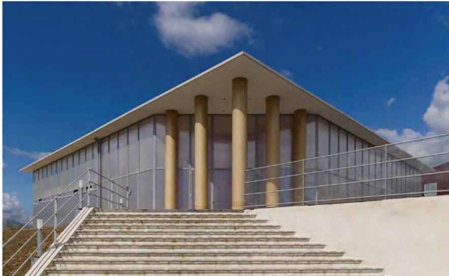
Şekil 10: Taşıyıcı karton tüplerin kolonlarda kullanımı (URL-11)
