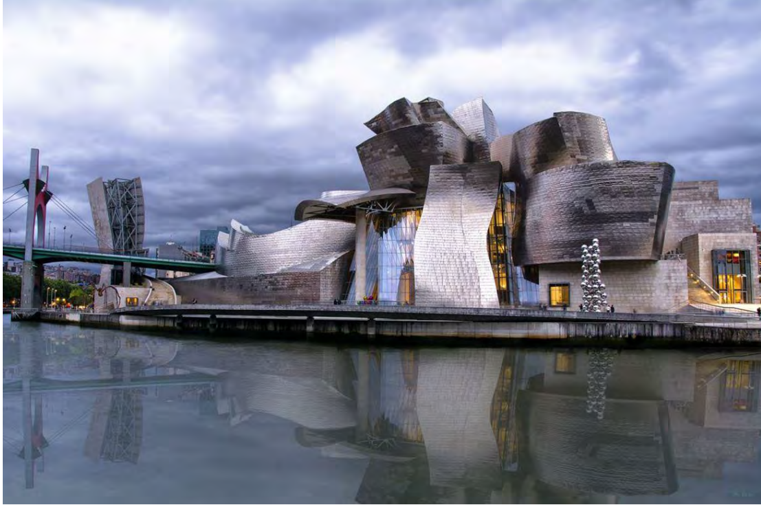
Görsel 1. Bilbao Guggenheim Müzesi Cephesi (Url-2)
