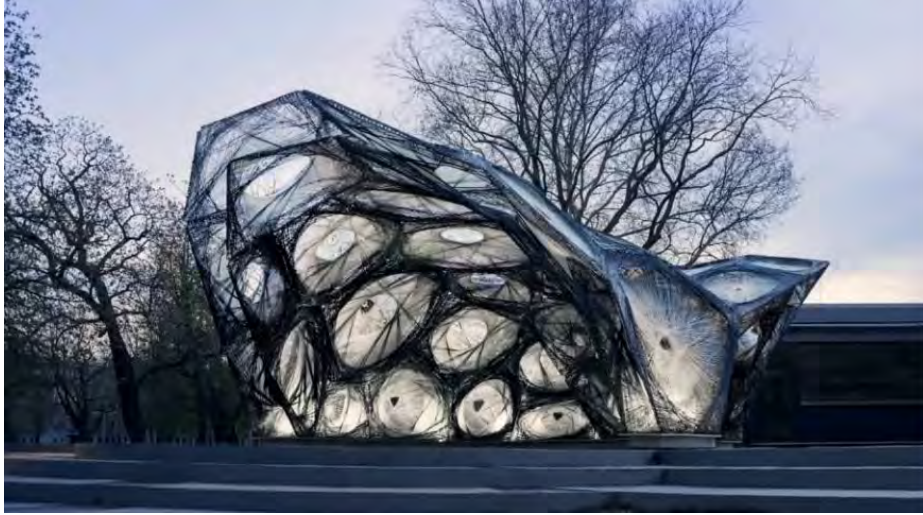
Şekil 1: ICD/ITKE Araştırma Pavyonu 2013-14 (Elshtwei, 2018, s.75).
