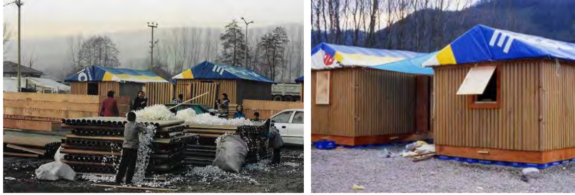
Şekil 20: Geçici kâğıt ev, Düzce, Türkiye, karton tüplerin atık kâğıtlarla doldurulması, 2000 (URL-20) (URL-21)
