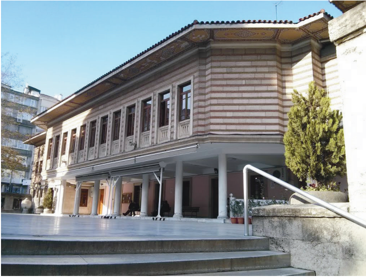
Şişli Camii Vakfı ve İdari Binaları
