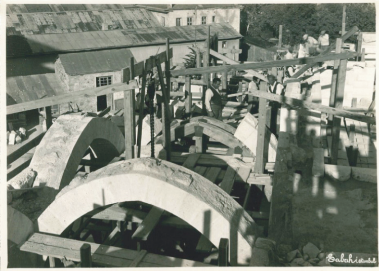
Camii İnşaatından Görünüm https://artsandculture.google.com
