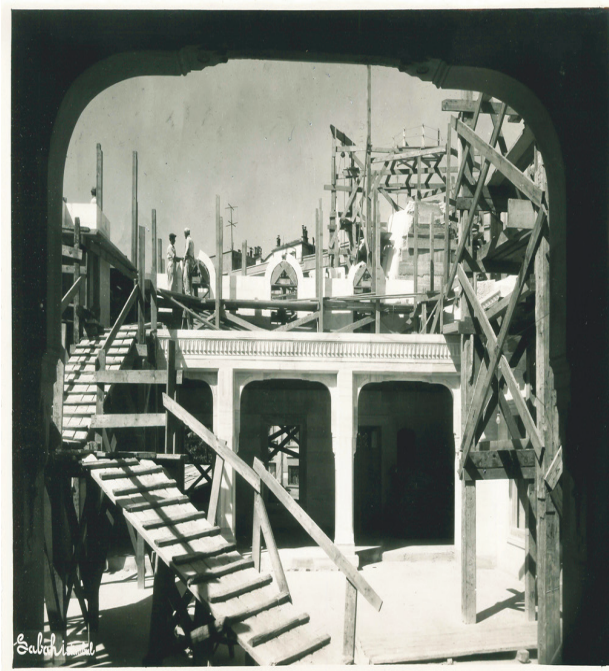
Camii İnşaatından Görünüm https://artsandculture.google.com
