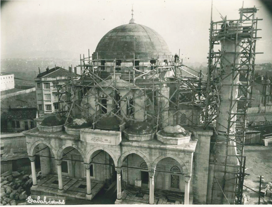
Camii İnşaatından Görünüm https://artsandculture.google.com
