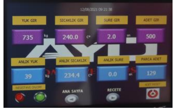
Şekil 2. SCADA Panel Görüntüsü
