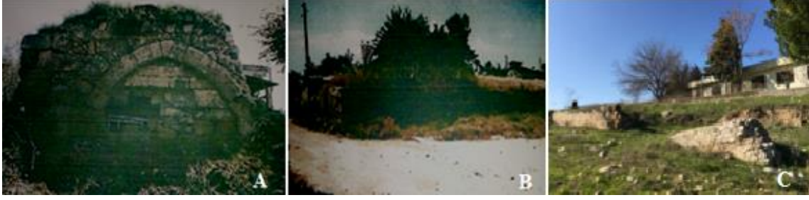
Fotoğraf 22: Misis A.(Geçitli Mahallesi) Tonozlu Yapı Kalıntısı 1 (Adana KVKBK Arşivi), B.(Geçitli Mahallesi) Tonozlu Yapı Kalıntısı 2 (Adana KVKBK Arşivi), C. (Eski Misis Mahallesi) Duvar Kalıntısı (Mozaik Müzesi Önü) (Ferruh TORUK Arşivi )
