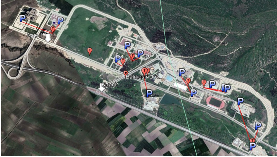
Şekil 4. Kampüs otopark ve trafo merkezlerinin genel görünümü.
