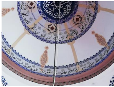
Fotoğraf 40. Kubbenin Kuzeyden Görünüşü
