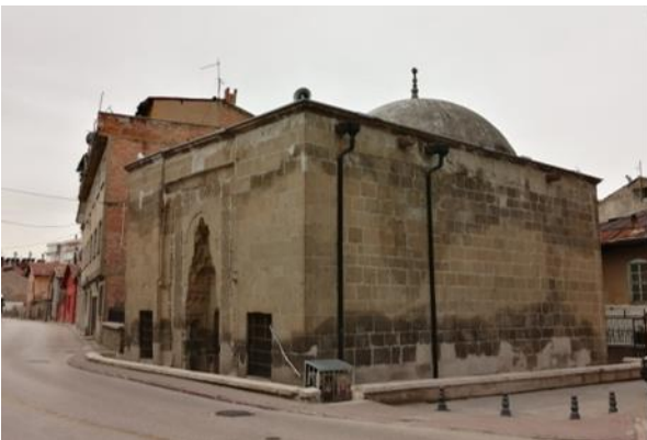
Şekil 7. Taş Mescit giriş cephesi ve iç mekanı [13]
