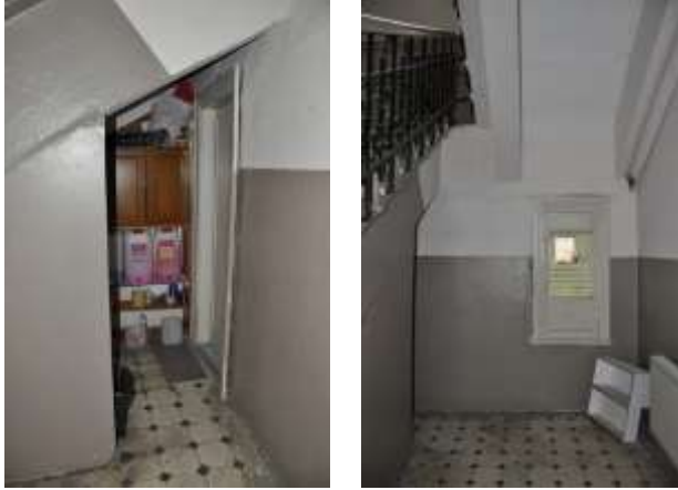
Resim 12-13. Zemin kat, görevli odasının merdiven boşluğuna açılan kapı ve penceresi
