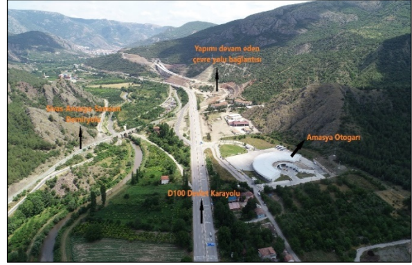
Fotoğraf 4. Amasya'da yapımı devam eden çevre yolunun giriş bağlantı kısmı. Arka planda Helvacı formasyonu içinde açılmış iki tünel ve onun hemen altından yine tünel içerinden geçen demiryolu görülmektedir.
