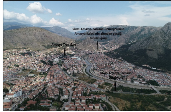
Foto 16. Amasya şehir merkezi içinde demiryolunun güzergahı ve Amasya Kalesi altında açılan tünel. Doğuya bakış.
