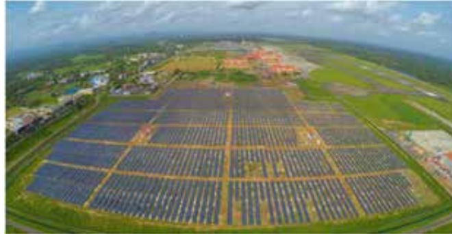
Şekil 3. Cochin Havalimanı Güneş Santrali (URL-3, 2021).
