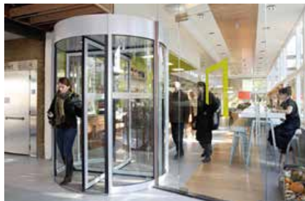
Şekil 7. Enerji üreten döner kapı sistemi (URL7)
