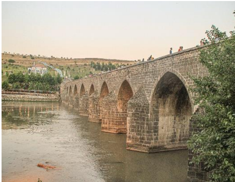
Resim 15. Köprün memba yüzeyindeki piramidal külahlı selyaranlar (Demir 2021)
