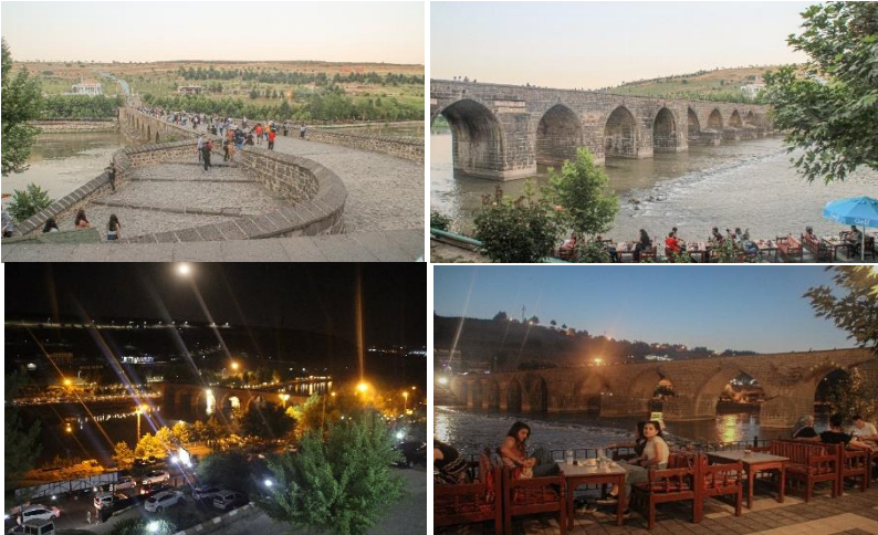
Resim 19. Köprü'nün restorasyon sonrası gece görünümü (Demir 2021).
