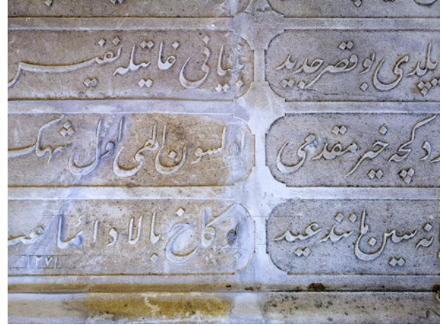
10 Restorasyon sonrası (Foto: Eyüp Arslan)
