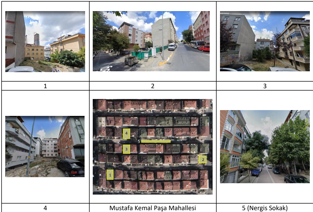
Görsel 7. İstanbul Avcılar İlçesi Mustafa Kemal Paşa Mahallesi'nde Ara Mekânlar (Google Maps, 2020).
