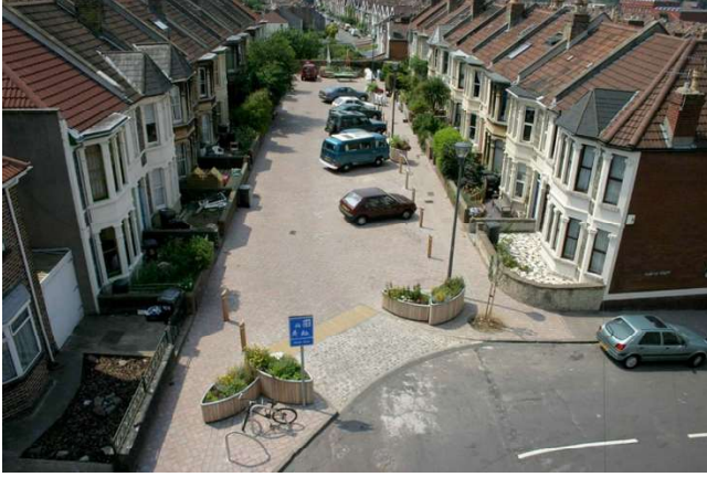
Şekil 5. Home Zone olarak düzenlenen bir sokağa rampa ile giriş (Interpave, n.d., 2021)
