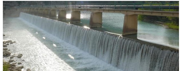
Şekil 6. Göksu Irmağı'nın aşağı havza sınırı olan ve anadrom balıklar için engel oluşturan Silifke sulama regülatörü (Silifke).
