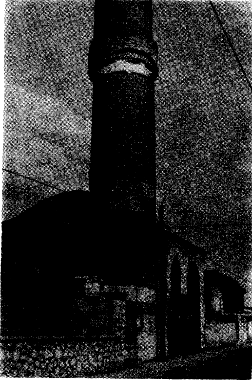
Res. 3 — Akşehir - Taşmedrese Mescit Bina
