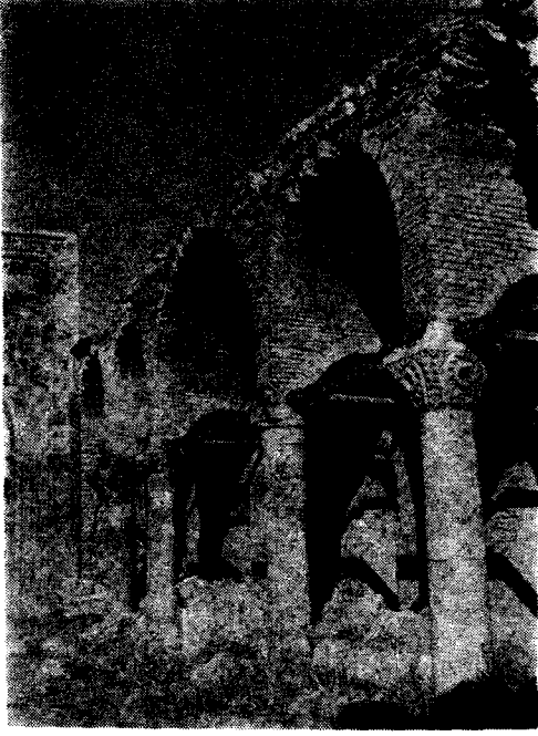
Res. 4 — Akşehir-Taşmedrese Avlu Revakları, Restarosyondan önce
