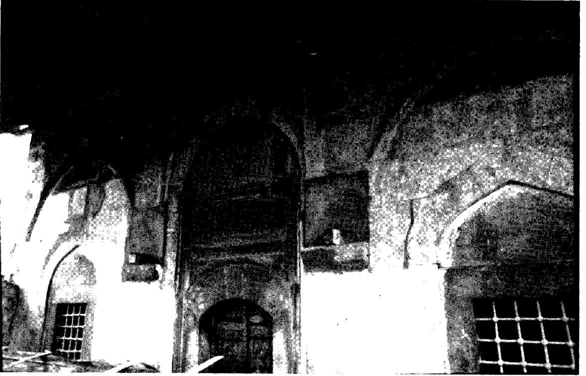
Resim: 3- Melik Danişmend Gazi Türbesi'nin kuzey cephesi
