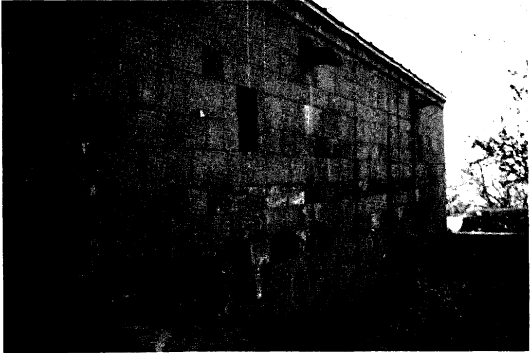
Resim: 6- Güney cephe
