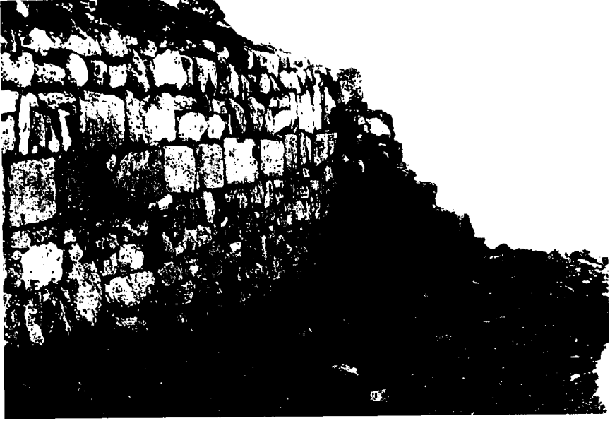
Resim 21: Nuhören Köyü Türbesi, kuzeybatı taraftaki yıkılmış kısım
