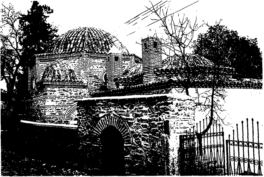
Resim 15: Halime Hatun Darü'l Hadisi, güneybatı cephe
