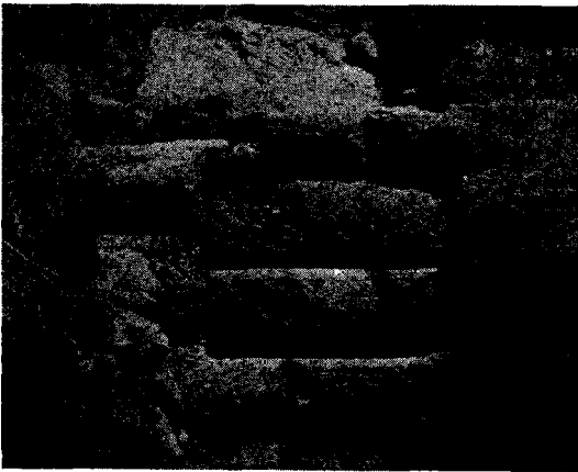
Abb. 3 — Tumulus von Belevi, Baunaht der Krepis.
