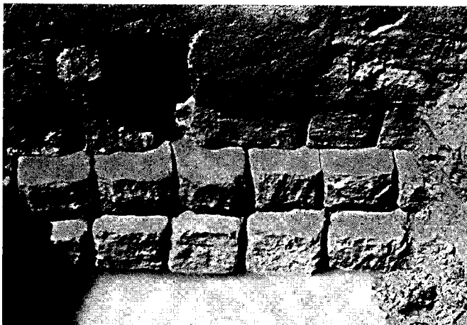
Fig. 7 — Fouille à l'intérieur du bassin. Les fondations du mur portant le stylobate du portique.
