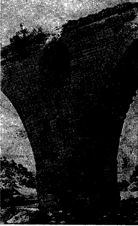
Res. 5 — Aynı Köprü'nün ayaklarından biri (Geç Antik Çağ ve Bizans devri malzemesinden faydalanılarak inşa edilmiştir).
