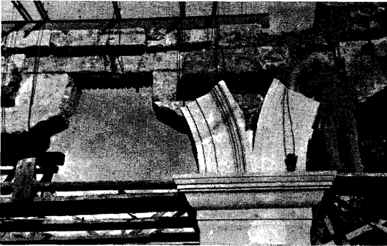
Res. 24 — Antalya - Hadriyan kapısının Restorasyon çalışmaları.
