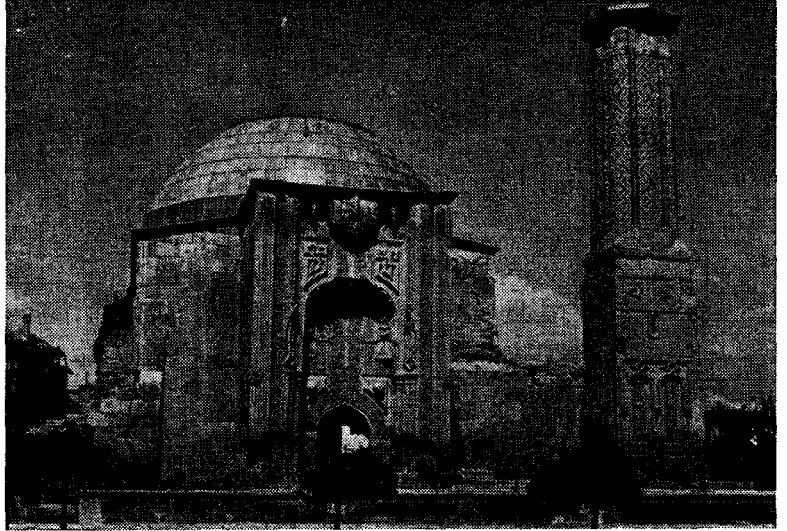
Res. 2 — Konya - İnce Minareli Medresesinin doğu yüzü, Cümle Kapısı ve Minaresinin görünüşü.
