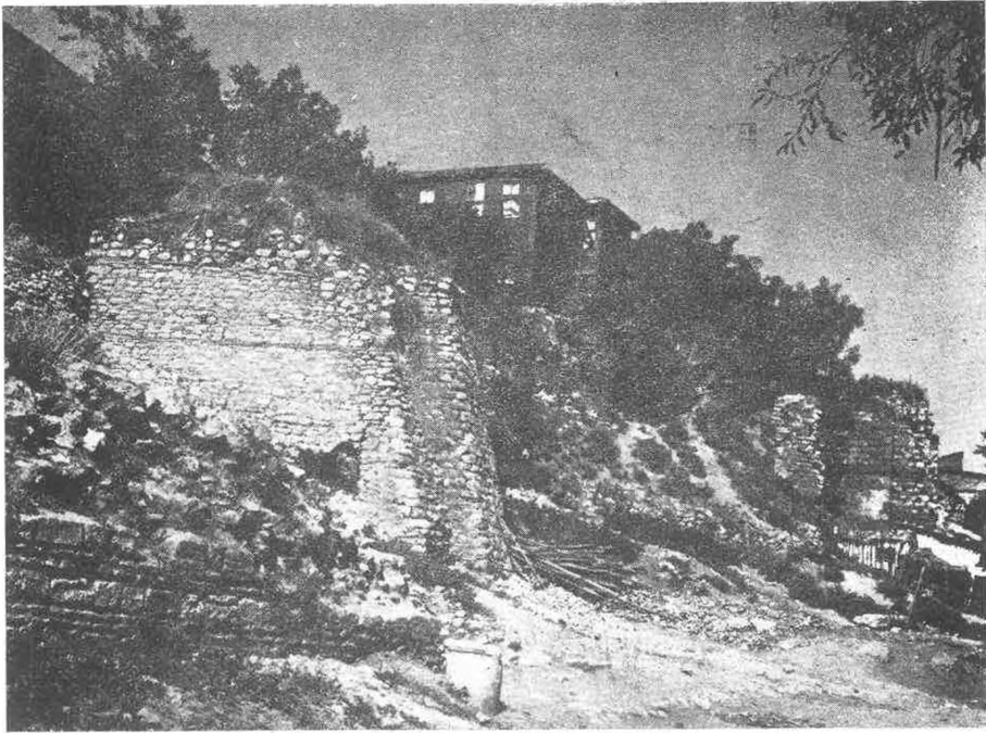
Res. 4 — Ayazına gerisindeki B-C istinat duvarı.
