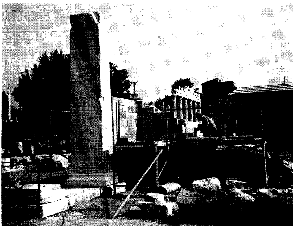
Abb. : 25 — Trajaneum. Wiederaufgestellter Marmorpfeiler am Durchgang von der Osthalle zum Ostkopfbau
