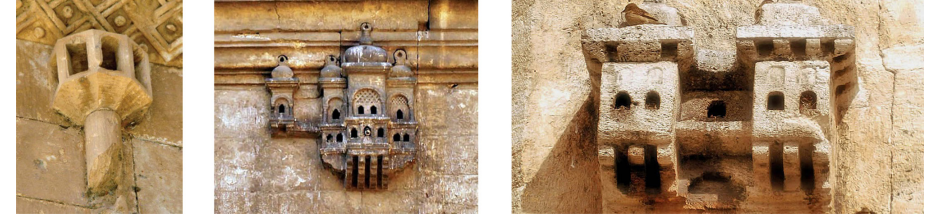
Görsel 2. (Soldan sağa) 1-İshak Paşa sarayı –Doğu Bayezid–18. Yy, 18. yüzyılda inşa edilmesine rağmen, Osmanlı mimari gelişimi dışında kalan Doğu Bayezid'de bulunan arkaik mimari özellikleri taşıyan kuş evi. 2- Ayazma Cami – Üsküdar – 18. Yy, Barok Mimari özellikleri taşıyan kuş evi. 3- Bali Paşa Cami – Fatih – 15. Yy, Klasik Osmanlı mimarisi.
