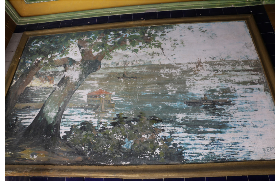
Görsel 4. Giriş Holü Sol Duvarında Kalan Duvar Resmi (E. Kolay, 2020)
