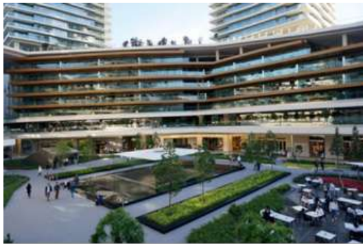
Görsel 18 . Zorlu Center Çatı ve Teras Bahçeleri Uygulamaları (https:14)
