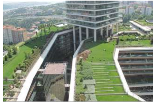
Görsel 18 – Görsel 19. Zorlu Center Çatı ve Teras Bahçeleri Uygulamaları (https:14)
