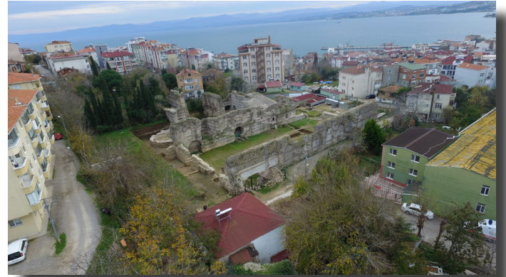
Resim 5. Balatlar Kilisesi yapı topluluğundan bir görünüm
