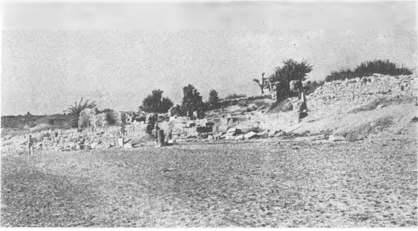
Res: 8 — İkinci avlunun deniz kenarındaki fasadı
