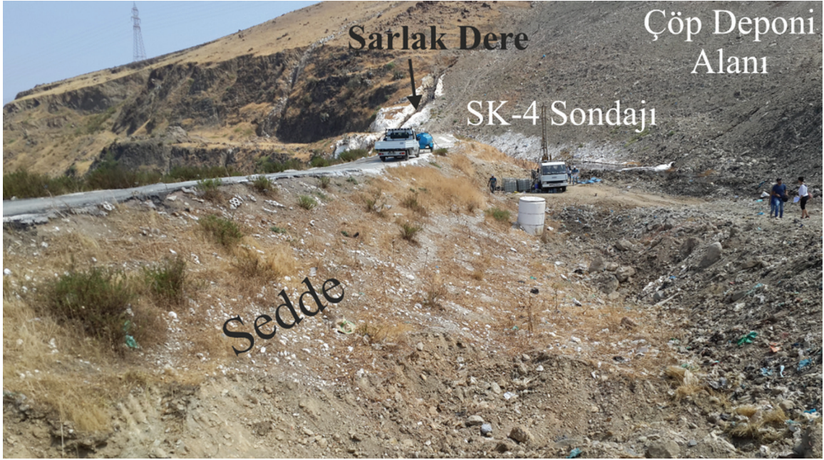
Şekil 2. Seddeyle katı atık depolama sahası arasında kalan hendekte açılmış SK-4 sondaj kuyusu.
