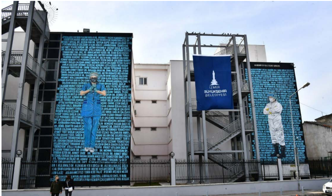
Şekil 12. Yarışma sonucu tamamlanan uygulama (URL-4, 2021).
