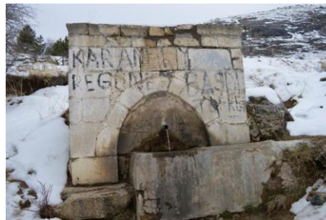
Resim-43. Dutluk Pınarı Çeşmesi Ön Cephe Genel Görünümü
