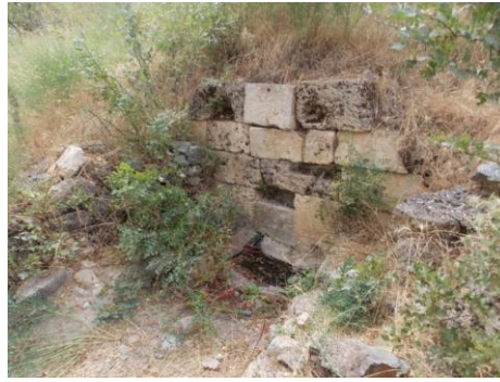
Resim-45. Ulu Cami Çeşmesi Ön Cephe Genel Görünümü
