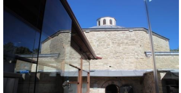
Şekil 13. Cimşit Bey Hamamı restorasyon sonrası güney cephe görünümü [16].
