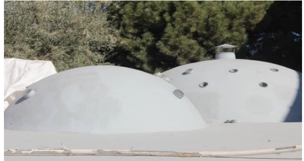
Şekil 14. Cimşit Bey hamamı restorasyon sonrası kubbe görünümü [16].
