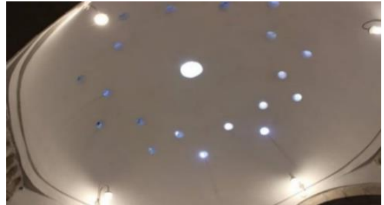
Şekil 4. Cimşit Bey Hamamı'nın doğal aydınlanmasını sağlayan ışık gözleri iç görünüm [16].
