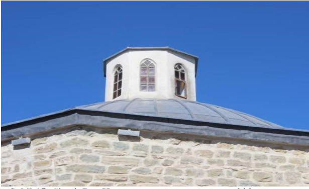
Şekil 15. Cimsit Bey Hammamı restorasyon sonrası ışıklık görünümü [16].
