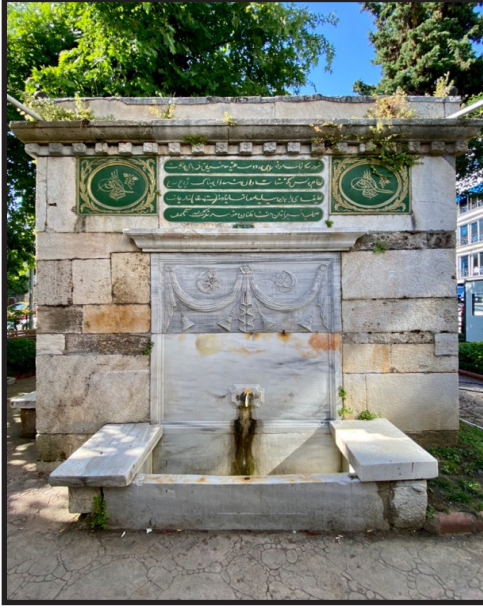
Ek-5 : Şehitler Çeşmesi'nin Güney Cephesi. Kaynak: Cenk Demir Özel Arşivi.
