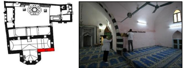
Şekil 26. Hoca Ahmet (Ayn Minare) Cami aks kayması bulunan harim güney duvarının doğu yönündeki duvarında yapılan GPR 2 taramaları ve konumları
