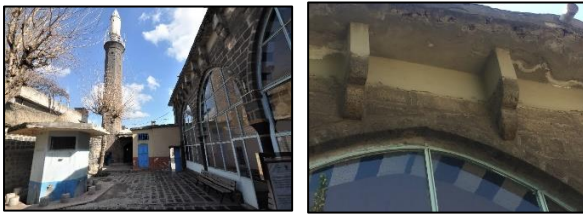
Şekil 6. Hoca Ahmet (Ayn Minare) Camide son cemaat yerinde silme üstlerine eklenen beton döşeme
