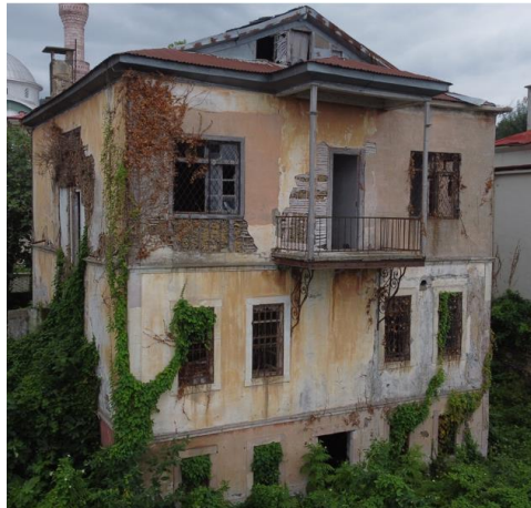
Görsel 13: Tiralizade Halis Bey Konağı Kuzey Cephesi
